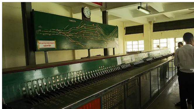
旧：電気連動装置（1941年 英国製）
